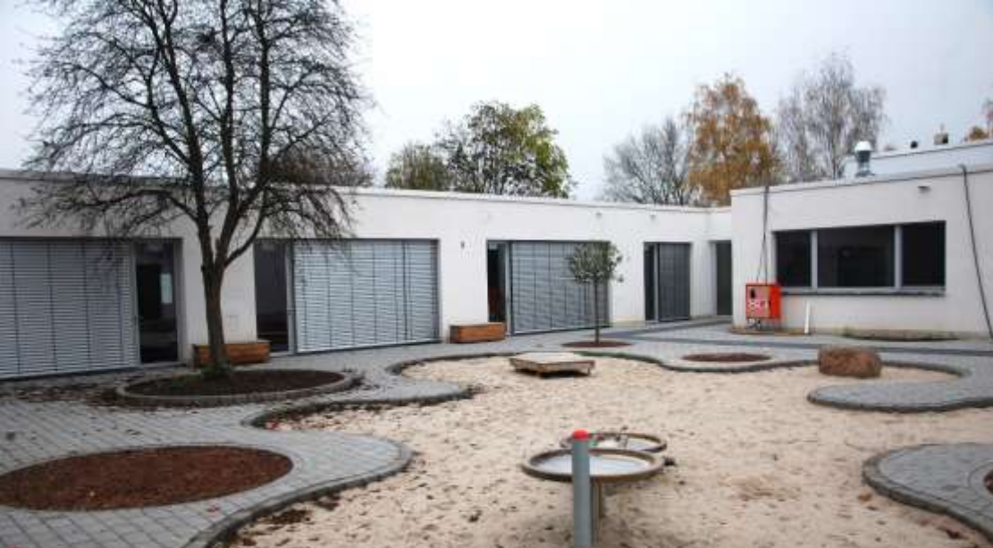
Baustelle Villa Kunterbunt Nikolaus in der Jungschargruppe
